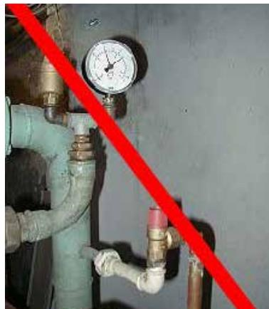
Rückzugsgebiet für Keime: Stutzen für Thermometer, Barometer oder Anschlüsse zur Entlüftung.
